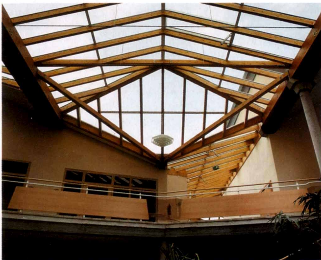
Der Giebel des Glasdaches leitet über in eine Galerie, die zum zweigeschossigen Café führt.
